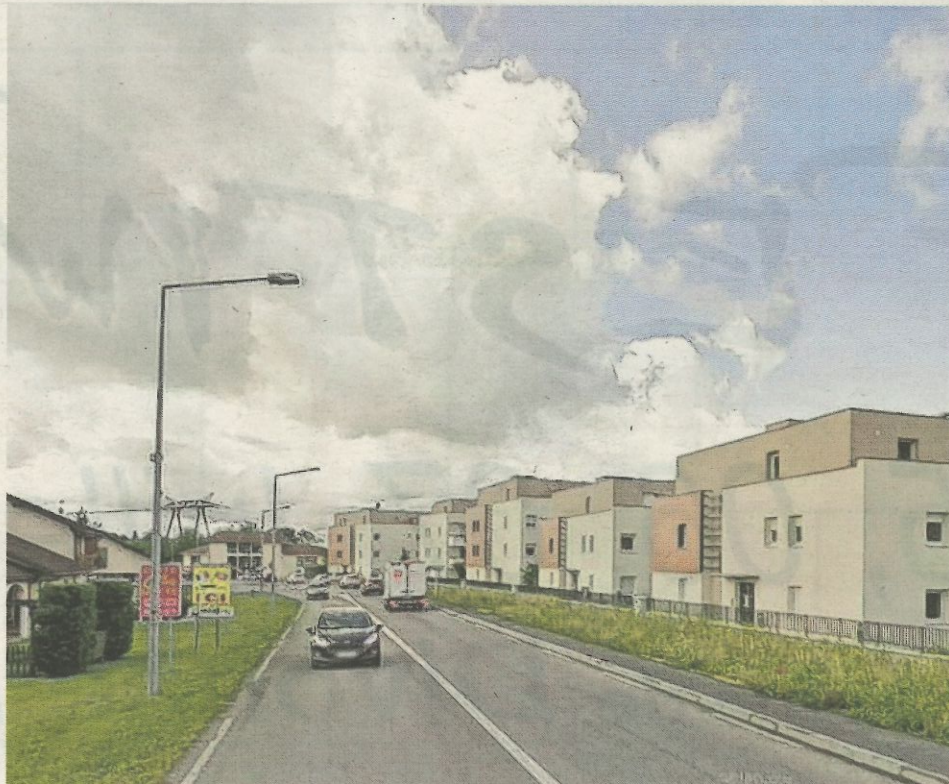
Les travaux comprendront un recalibrage général de la RD 1005 de l'entrée nord de Maconnex.
