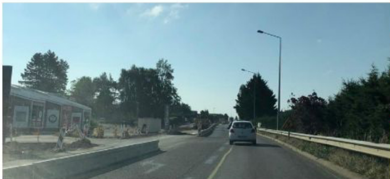
Les travaux de la véloroute ont débuté sur la commune d'Ornex.
