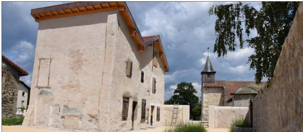
La grange dimière restaurée a belle allure et complète un ensemble centre-église et la Tour.
