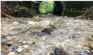
Ces travaux sur Le Lion font partie du contrat corridors « Vesancy-Versoix ».
