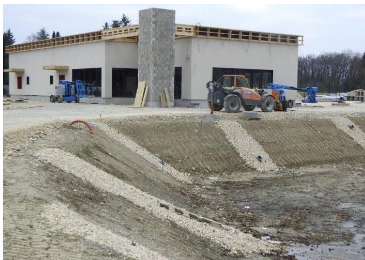
Le nouveau lieu de restauration rapide est construit à l'arrière d'un bassin de rétention en cours de rénovation et d'agrandissement. Photo Le DL /G.Do.
