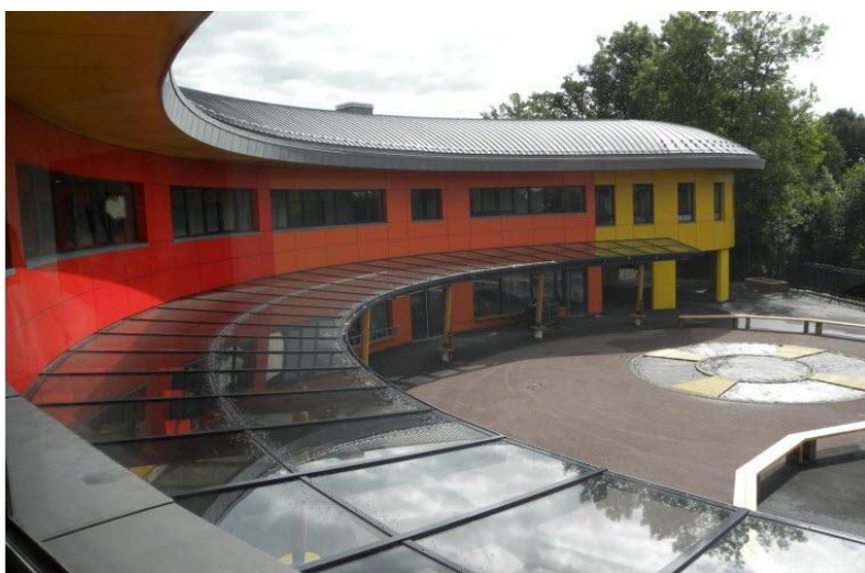
Des travaux nécessaires à l'école de Villard. Photo Le DL /G.Do.
