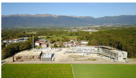
Chantier du collège
