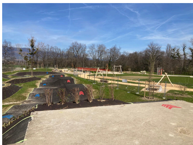
Parc des hérissons en construction
